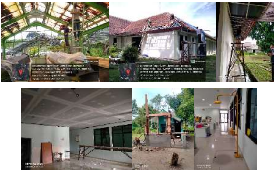
Gambar 41. Perbaikan dan pemeliharaan kantor
